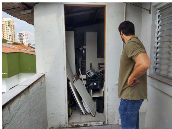
Figura 36 - Sacada nos fundos do imóvel nº 1803
