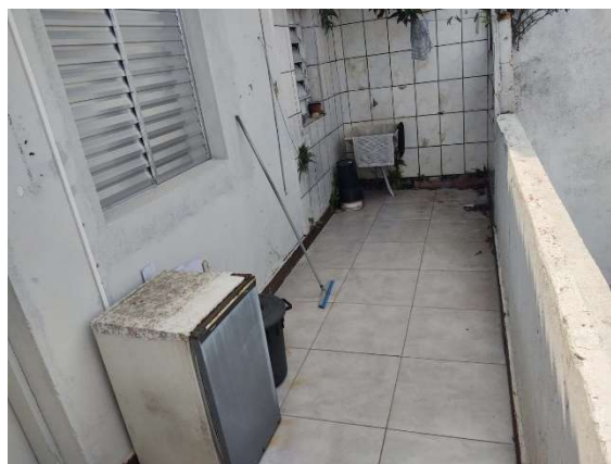
Figura 37 – Sacada nos fundos do imóvel nº 1811
