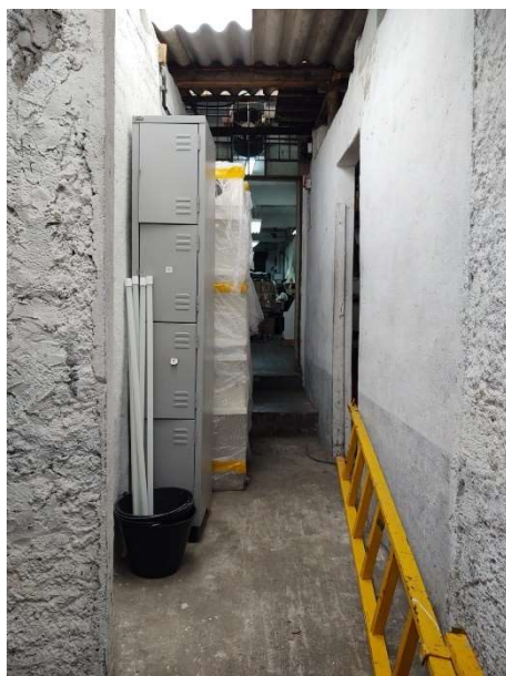
Figura 40 – Corredor de acesso ao galpão
