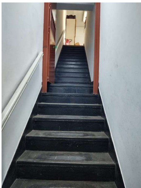
Figura 20 – Escada de acesso ao imóvel nº 1803
