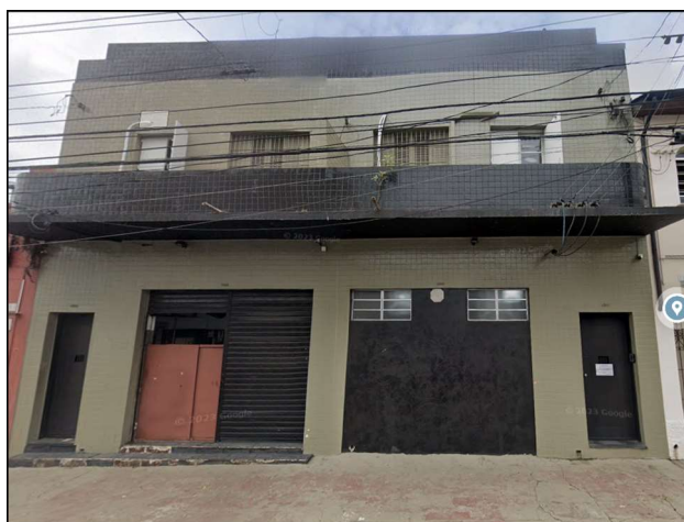
Figura 4 – Vista frontal do imóvel – As duas portas de entrada menores correspondem a imóveis originalmente residenciais (números 1803 e 1811), situados no pavimento superior, e as duas portas maiores (de aço e de enrolar) correspondem a salões comerciais (números 1805 e 1809)
