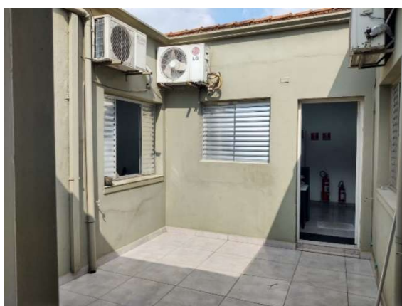
Figura 22 – Área interna de iluminação e ventilação entre os imóveis nºs 1803 e 1811
