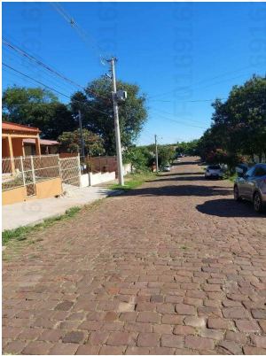
Vista da Rua
