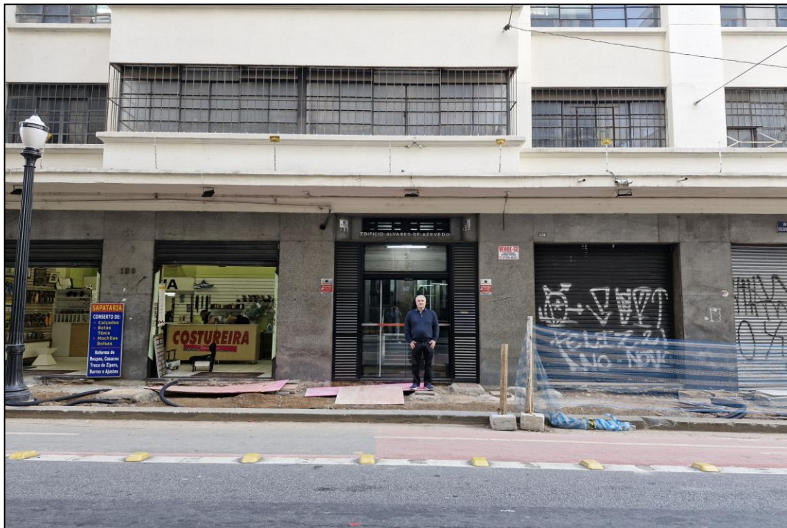
Foto nº 4: Vista do acesso para o interior do Edifício.
