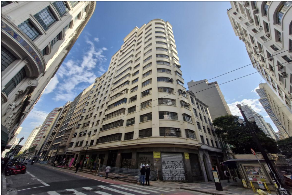
Foto nº 3: Vista da fachada do Edifício Alvares de Azevedo, onde se localiza a unidade em estudo 2 .
