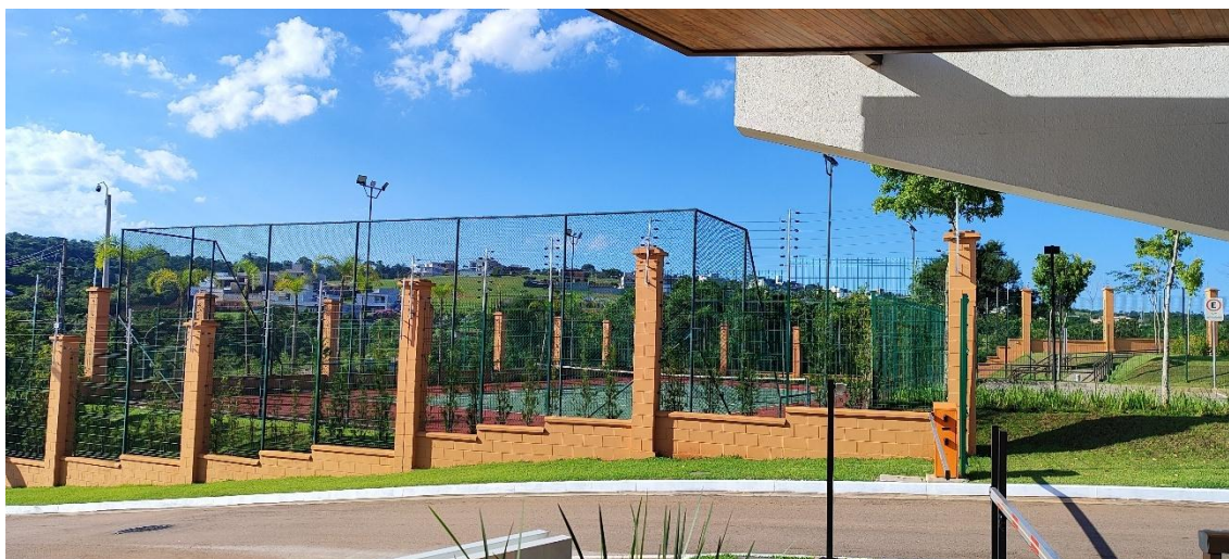
Figura 2.4 – Identificação da via pavimentada
