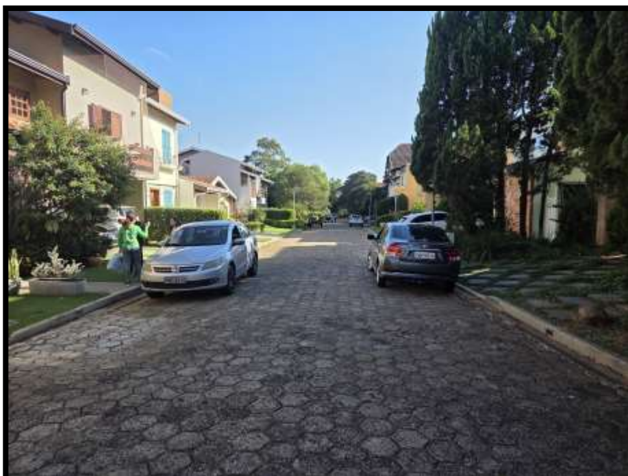
2. RUA INTERNA DO CONDOMÍNIO.
