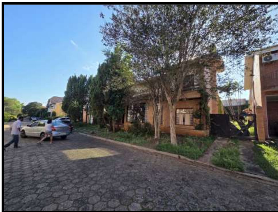
2. Fachada geral do imóvel.
