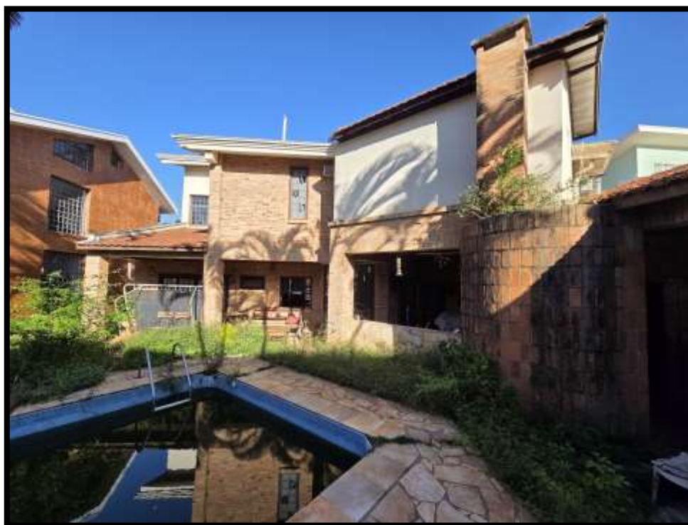
3. Fachada dos fundos do imóvel, mostrando a piscina.
