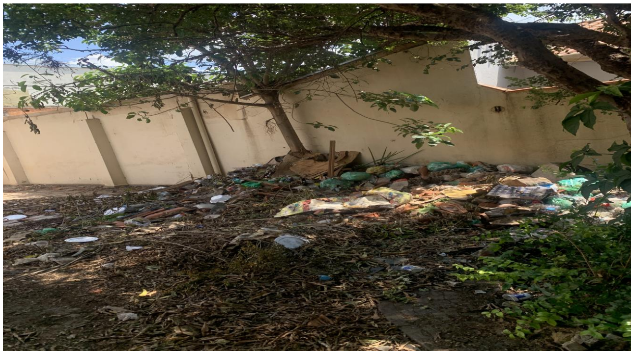
Foto 04 – Muito lixo e entulho acumulados na entrada do imóvel.
