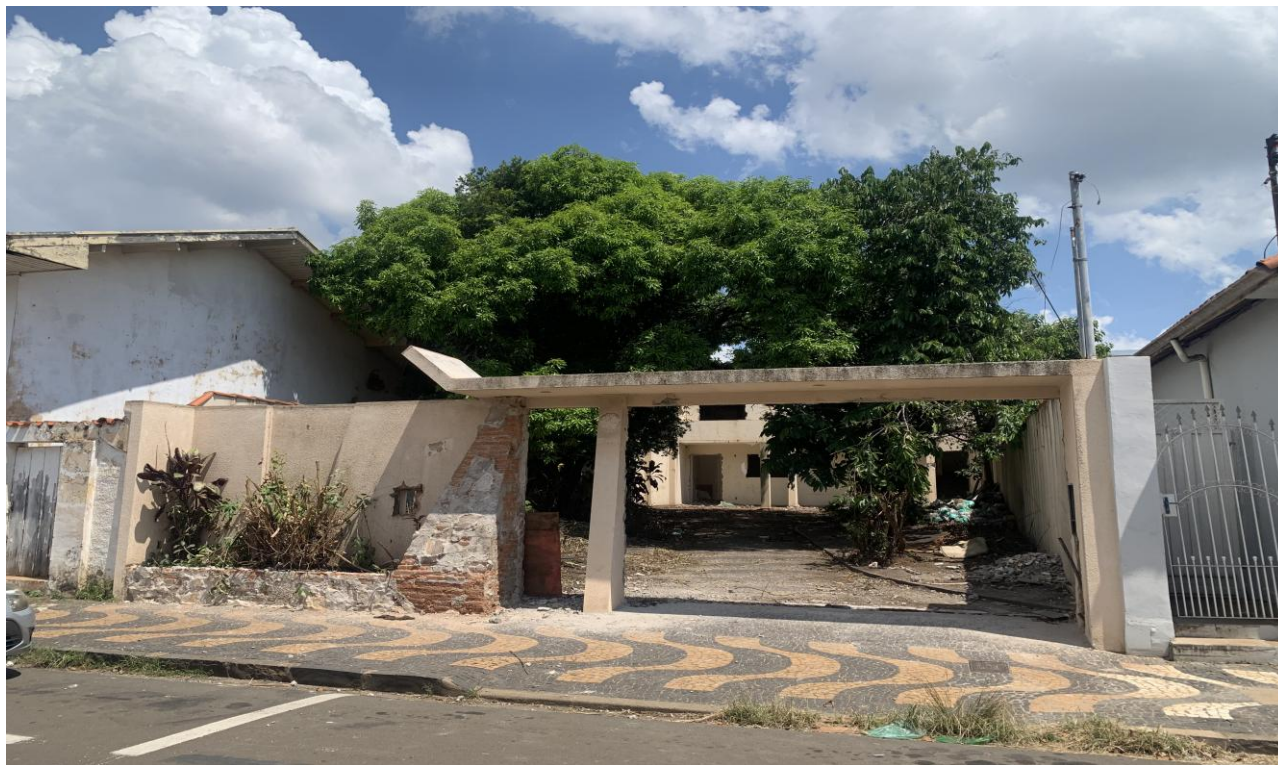
Foto 02 – Frente do imóvel avaliado.
