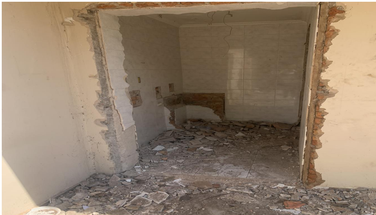
Foto 07 - Entrada pelo lado esquerdo da propriedade.
