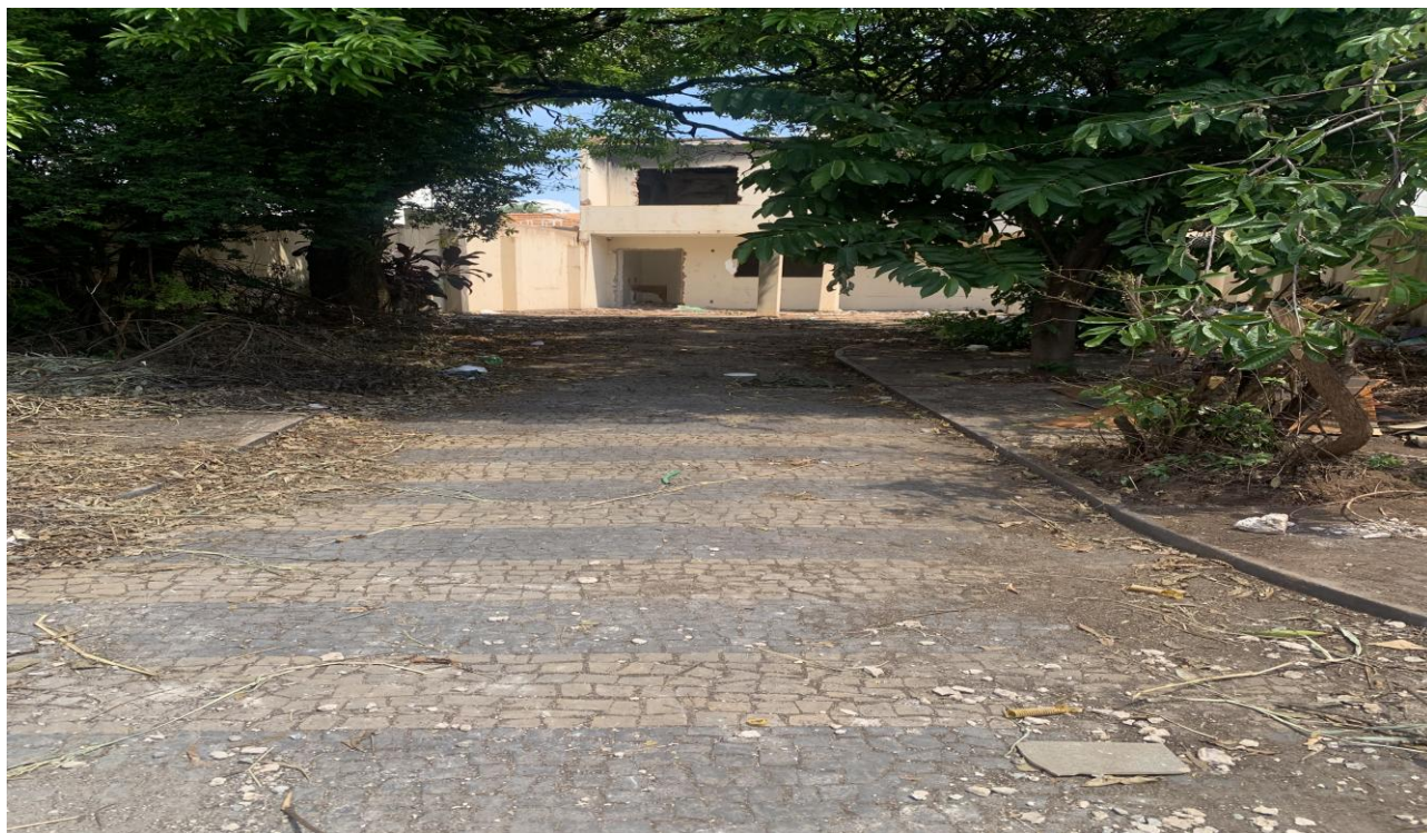
Foto 03 – Área da entrada do imóvel.
